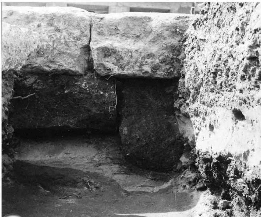
Fig. 161 , Fondation du mur ouest des magasins orientaux, côté « cour »; vers l'axe du temple (qui se situe un peu au nord, hors du cliché vers la gauche), l'assise inférieure devient beaucoup plus épaisse qu'auparavant au sud; dans la coupe nord du terrain, la zone médiane claire correspond à la couche de sable de rivière mise en place par H. Chevrier (cliché M. Azim, 13 février 1984)
