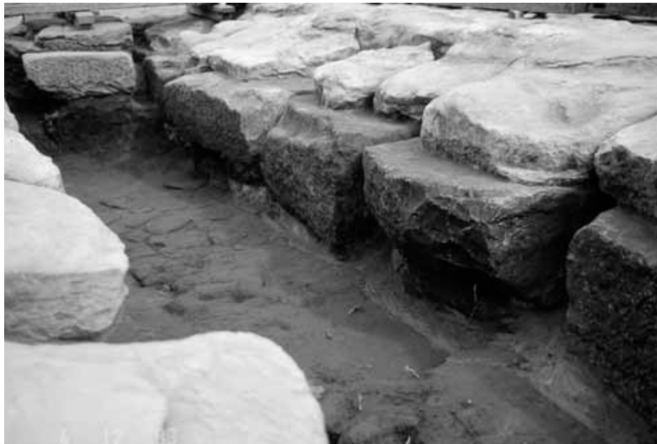
Fig. 195 , DB2.e. Db, fondations du mur est; deux assises sont dégagées, une troisième s'amorce
