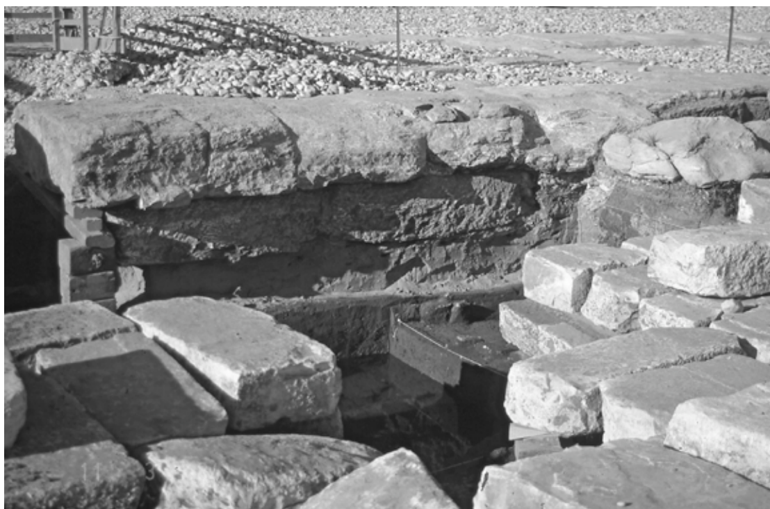
Fig. 120 , La zone 4 en fin de chantier; à gauche, la fondation de grès est provisoirement reprise sur une poutre de bois; en fond de tranchée, un sondage a été poussé jusqu'à ce que la nappe phréatique l'arrête (cliché M. Azim, 11 mars 1984, n°LX74-032)
