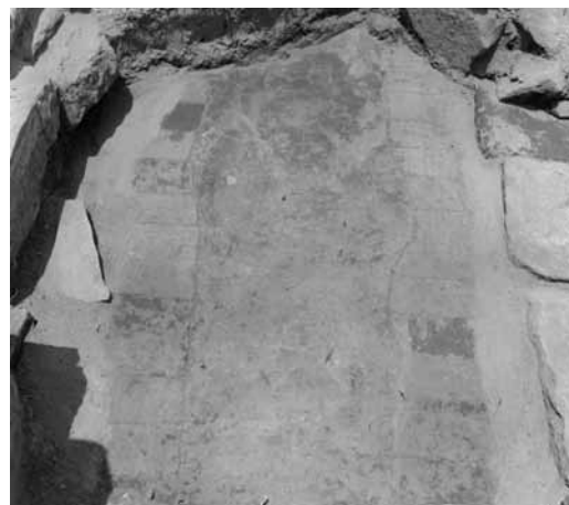
Fig. 136, Déformations apparentes des murets délimitant la maçonnerie Y dans la partie orientale de DB1.n.10 (cliché T. Zimmer, 29 avril 1984, CFEETK n° 27767)
