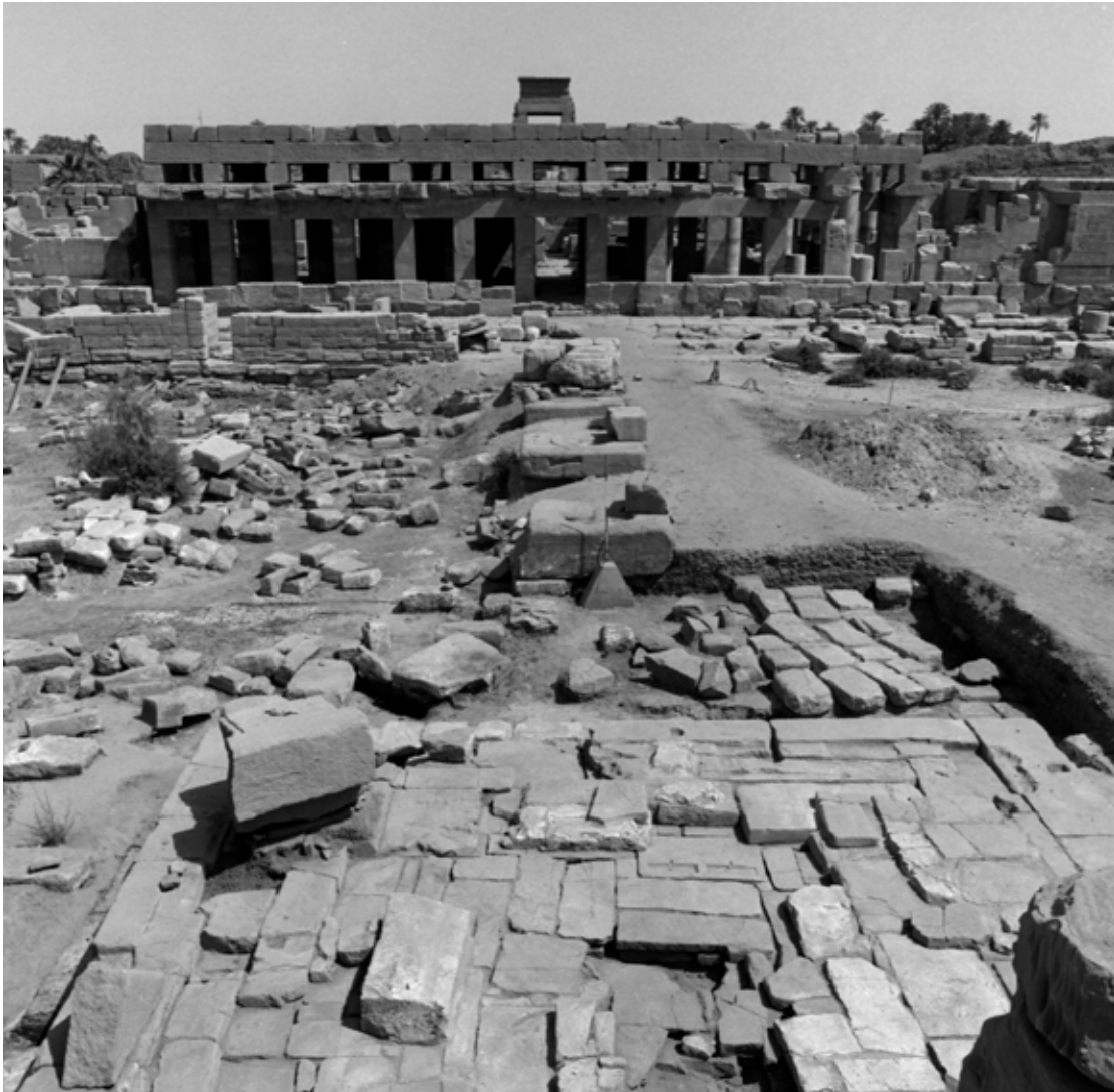
Fig. 5. La « cour du Moyen Empire » après les dégagements de J. Lauffray, vue vers l'est, CNRS/CFEETK, 15637
