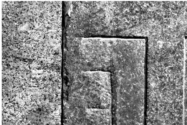
fig. 4 Inachèvement des redans près des joints verticaux.
