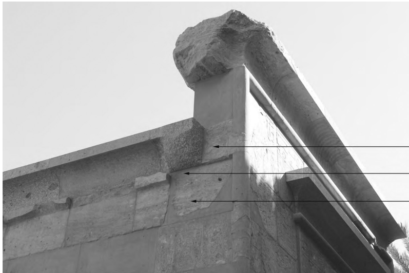
a. Angle nord-ouest : tore vertical inachevé
