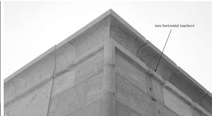
d. Angle nord-est : tore vertical inachevé
